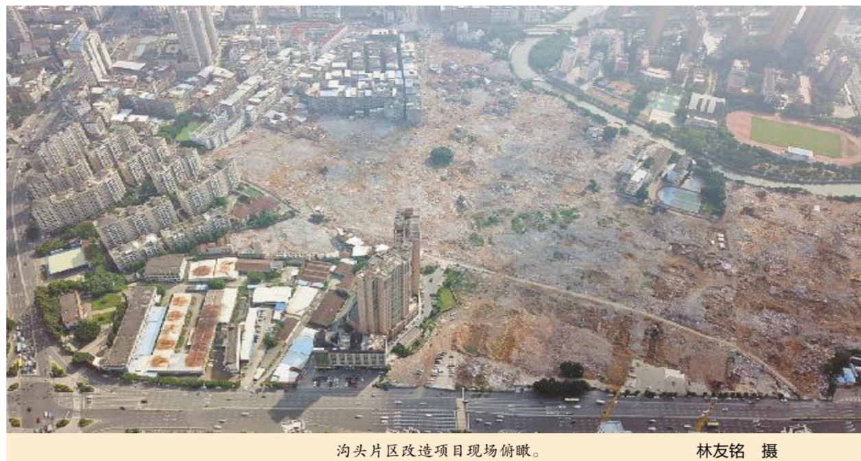
沟头片区改造项目现场俯瞰。 林友铭 摄
