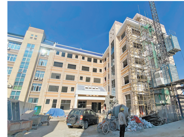
东桥镇卫生院病房楼扩建工程主体完工，将进行内部装修。
