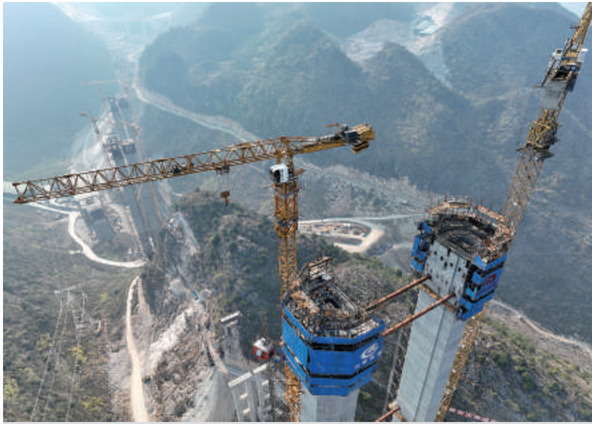
新春伊始,贵州花江峡谷大桥建设现场一派繁忙。花江峡谷大桥是六安高速公路的控制性工程之一,建成后主桥桥面与谷底的北盘江距离达625米,预计2025年竣工。 新华社发
