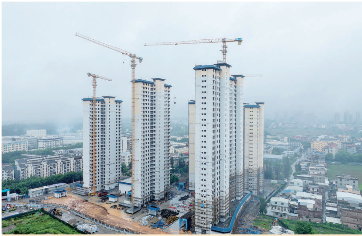
图为赤港片区改造一期安置房项目实施,改善群众人居环境。全媒体记者 陈斌 摄
