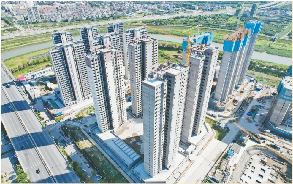
木兰溪畔坂头西片区安置房加快建设进度,一溪两岸,连片发展,拉开框架,城市变大变美。
