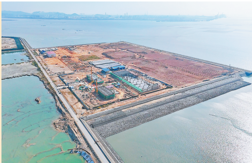
兴化港区涵江作业区1—3号泊位码头建设战况。
