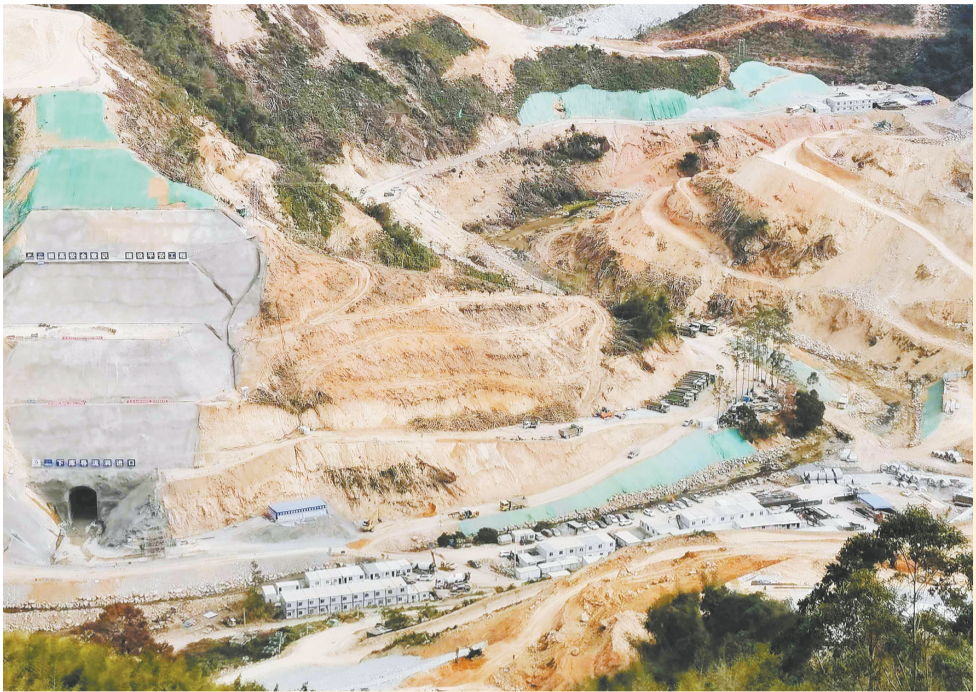
仙游木兰抽水蓄能电站施工现场,项目建设有序推进。
