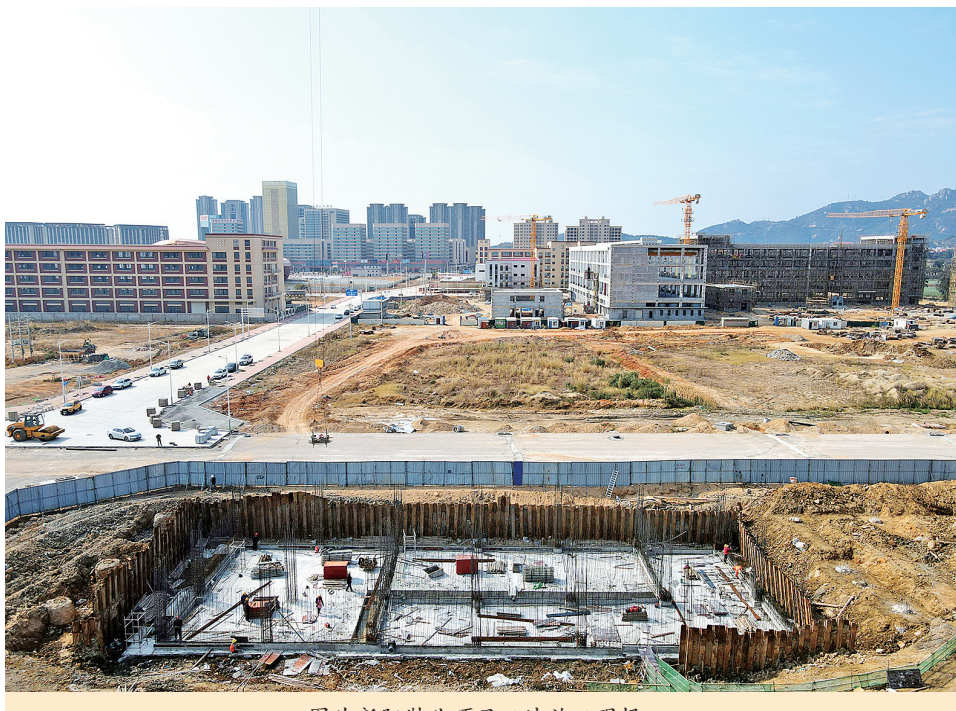
图为新阳鞋业项目工地施工现场。
