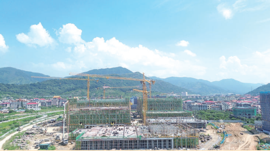
西许“专精特新”产业园加快建设。
