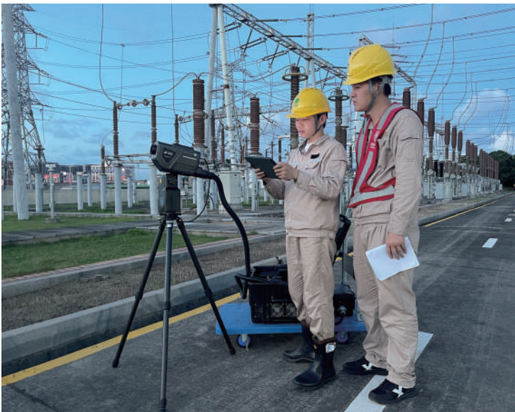
莆田供电公司工作人员利用激光清除漂浮物。
