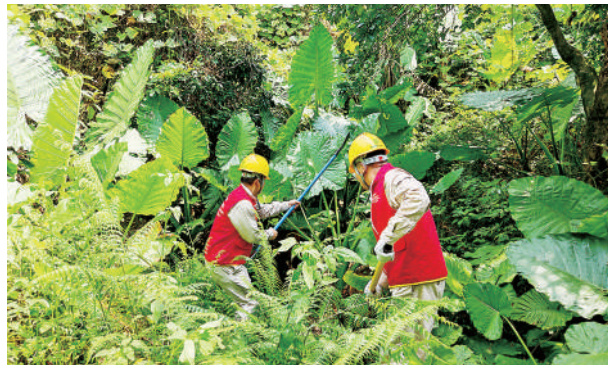
莆田供电公司工作人员正在清理超高树木。沈乙平 摄
