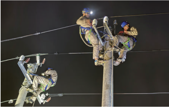
莆田供电公司抢修人员彻夜奋战开展抢修工作。
