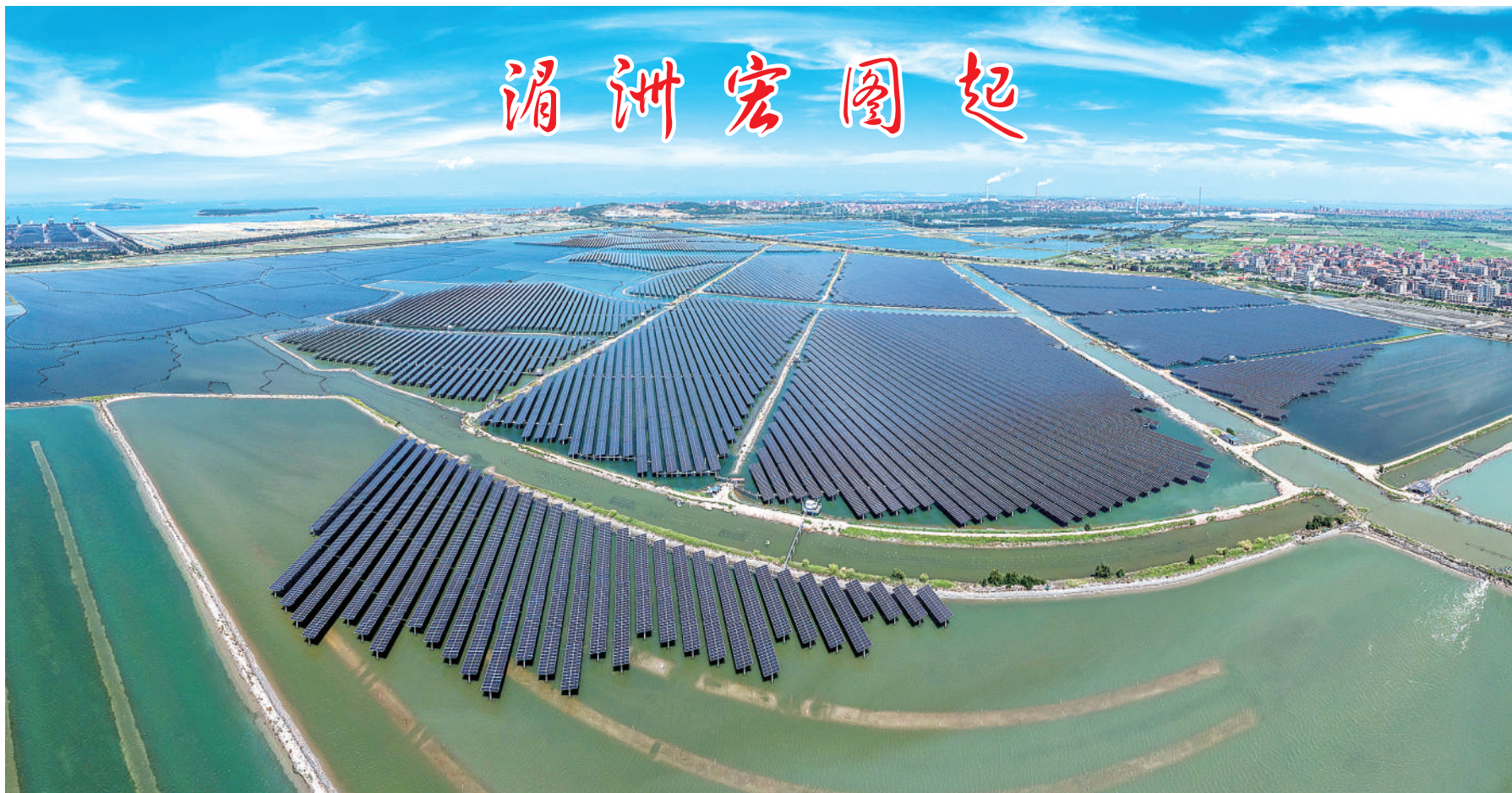
湄洲党工委、管委会及纪检监察工委昨日正式挂牌运行，我市岛岸一体发展掀开了崭新篇章。图为国投云顶湄洲湾（莆田）新能源有限公司东乌垵A区100MW渔光互补光伏电站项目现场，一排排深蓝色光伏板在阳光下熠熠生辉，成为绿色高质量发展的新引擎。
