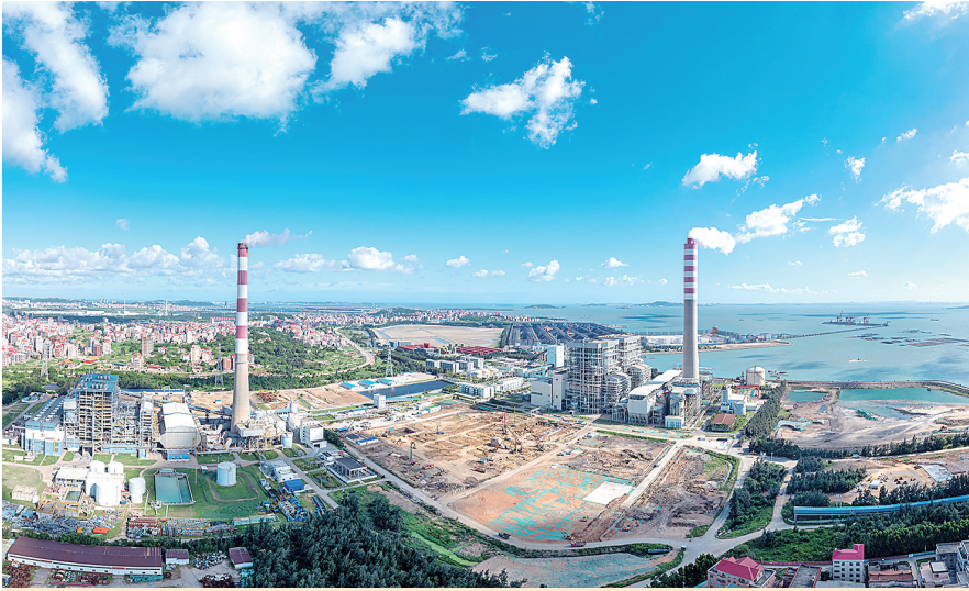
图为总投资超50亿元的国投湄洲湾第三发电厂2×660兆瓦机组项目，现场施工加紧推进。 全媒体记者 陈斌 摄
