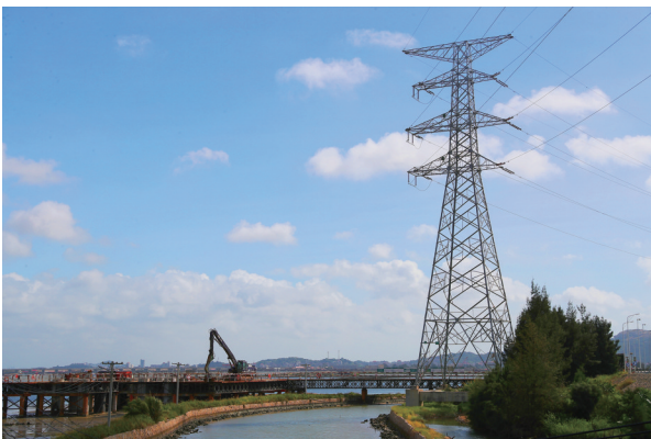
莆田供电公司创新施工方式降低电网建设中的污染风险。
