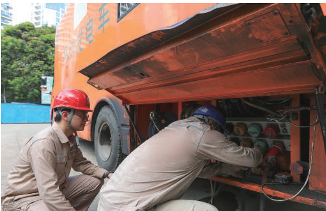
莆田供电公司工作人员将移动发电车接入比赛场馆配电系统。
