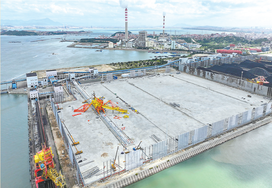
国投湄洲湾能源供应基地项目主体结构已基本完成。
