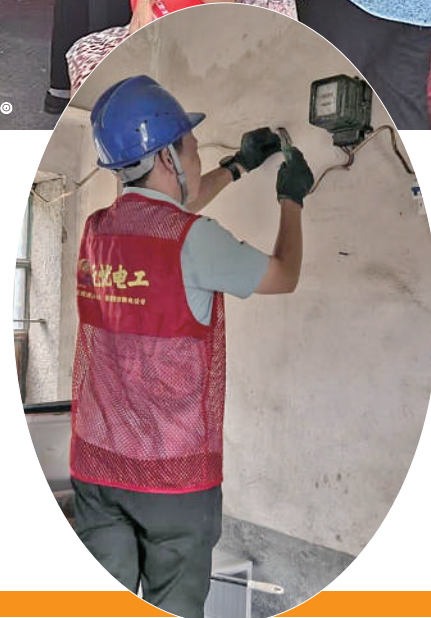
“无忧电工”志愿者为残疾人家庭检修用电设施。
