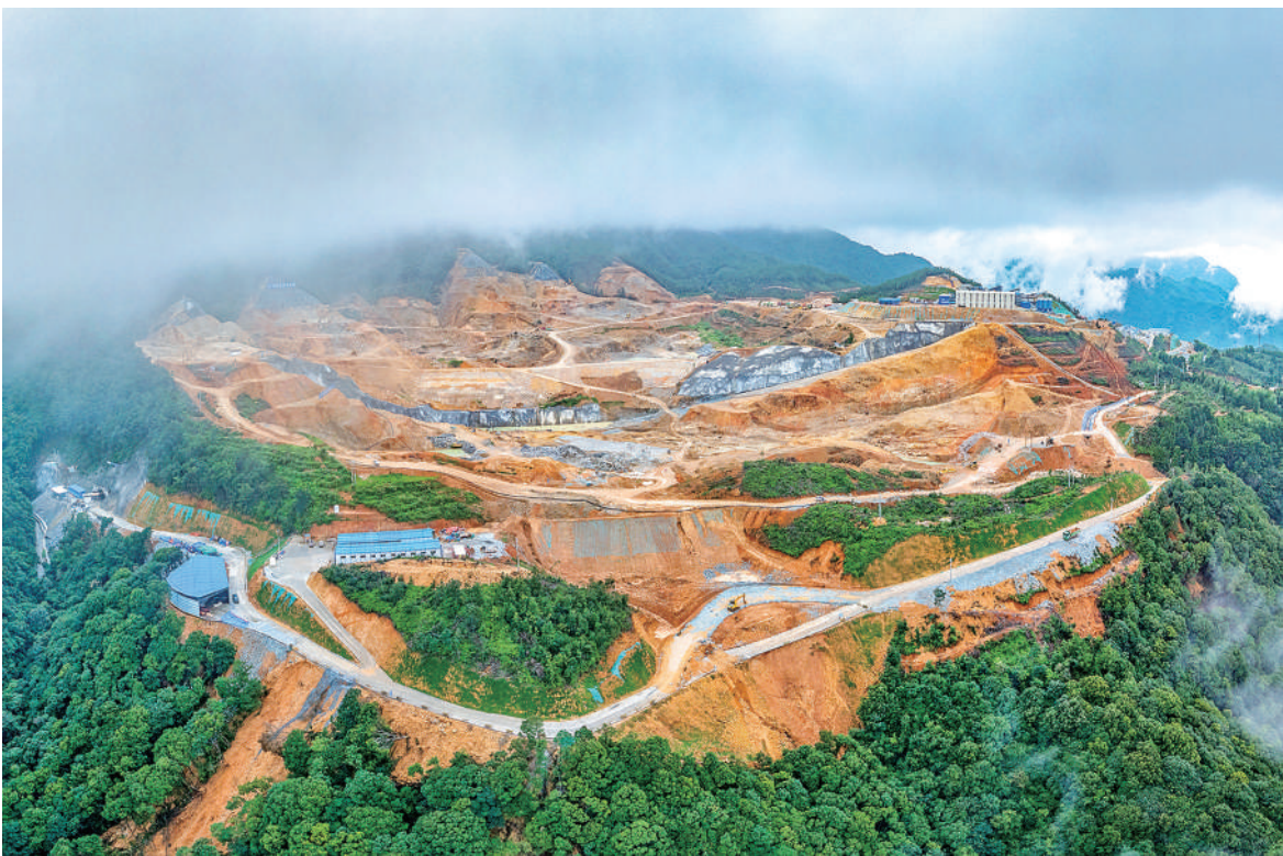
仙游木兰抽水蓄能电站是国家抽水蓄能中长期发展规划(2021—2035)中的“十四五”重点实施项目。图为9月9日,该项目建设现场,数十台机械轰鸣,运输车辆穿梭,主坝填筑区域施工正酣。全媒体记者 蔡昊 摄
