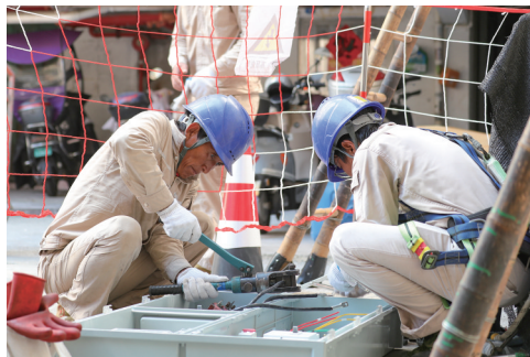
施工人员正在调试表箱内的设备。
