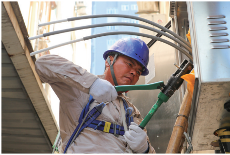
电力施工人员正在安装新表箱。
