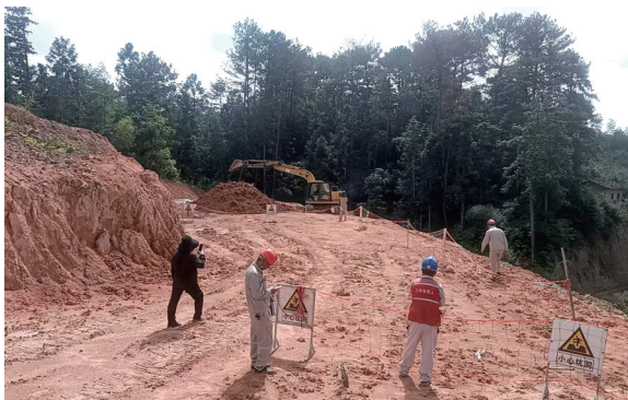
图为施工现场。
