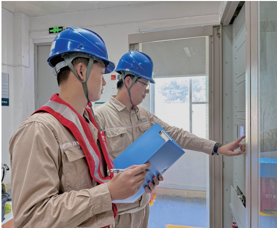
工作人员对母线保护装置开展功能检验。
