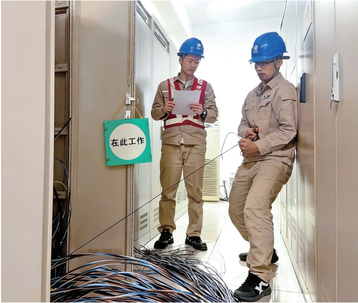
变电检修全业务核心班组进行电缆布线工作。
