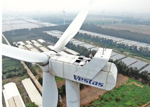
在风机塔顶，巡检员出舱检测风传感器等外部设备。蔡小康 摄
