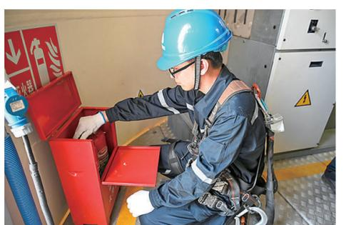
在风机塔底，运检员确认灭火器压力值在正常范围。
