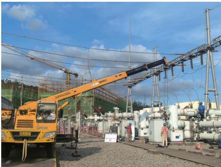
莆田供电公司顺利完成220千伏林宅变电站电器解体大修任务。
