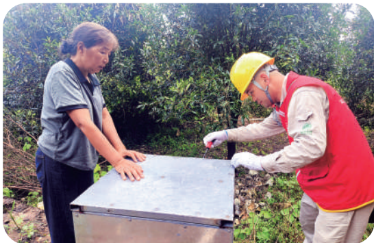
共产党员服务队队员走进田间地头,检查用电设施安全。
