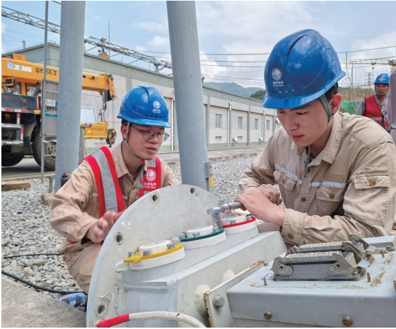
莆田供电公司工作人员加强电网设备消缺。
