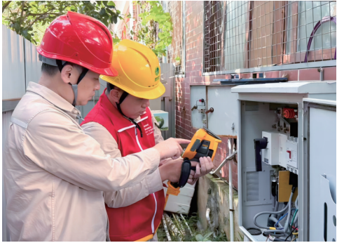
保电人员在我市九鲤湖景区开展用电设备检查。
