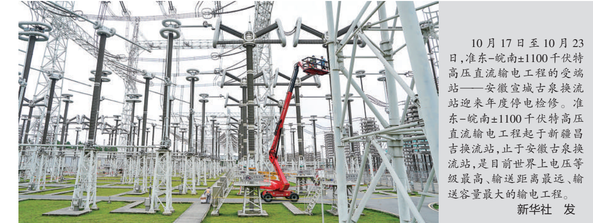
10 月 17 日至 10 月 23 日，淮东—皖南±1100 千伏特高压直流输电工程的受端站——安徽宣城古泉换流站迎来年度停电检修。淮东—皖南±1100 千伏特高压直流输电工程起于新疆昌吉换流站，止于安徽古泉换流站，是目前世界上电压等级最高、输送距离最远、输送容量最大的输电工程。
