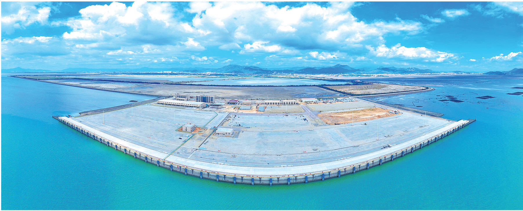
图为兴化港区涵江作业区1—3号泊位工程建设现场。
