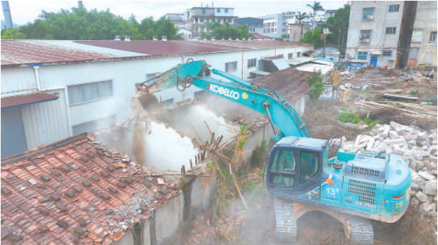
梧塘镇拆除最后两家涉迁企业，力争高林街北伸路段元旦前实现全线通车。
