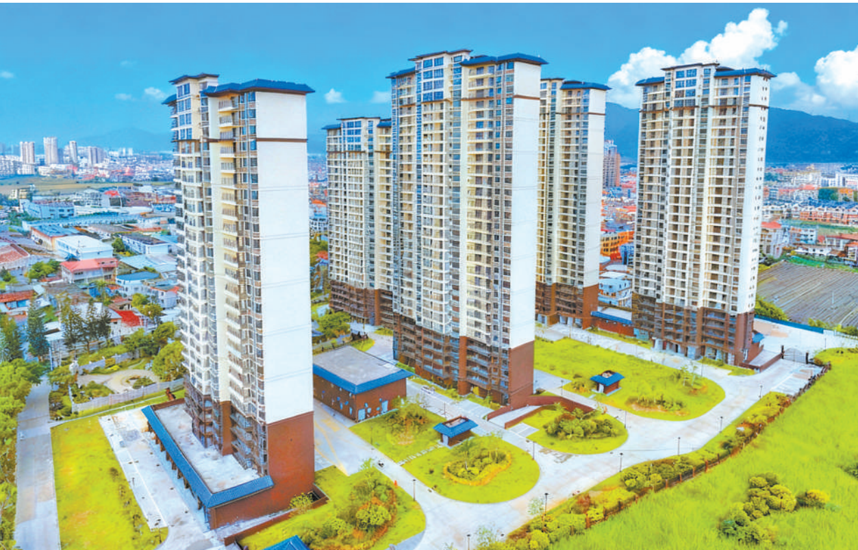
赤港安置房冲刺扫尾，年内可交付使用。
