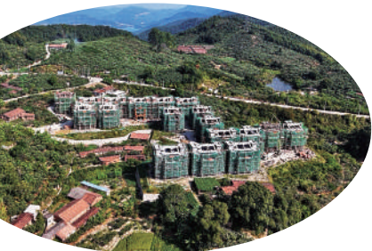
▲白洋村幸福家园新建区项目(一期)封顶。
