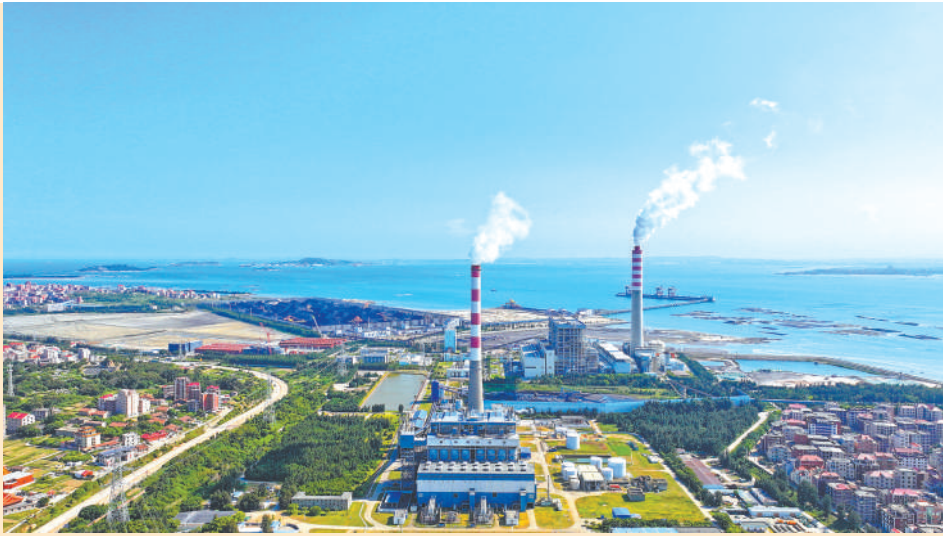
湄洲湾火电厂。
