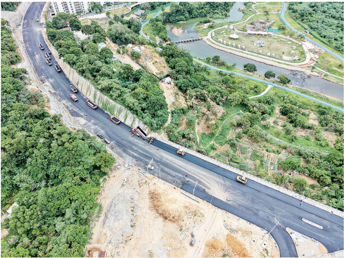
航拍下的泗华郊野公园配套道路项目现场。
