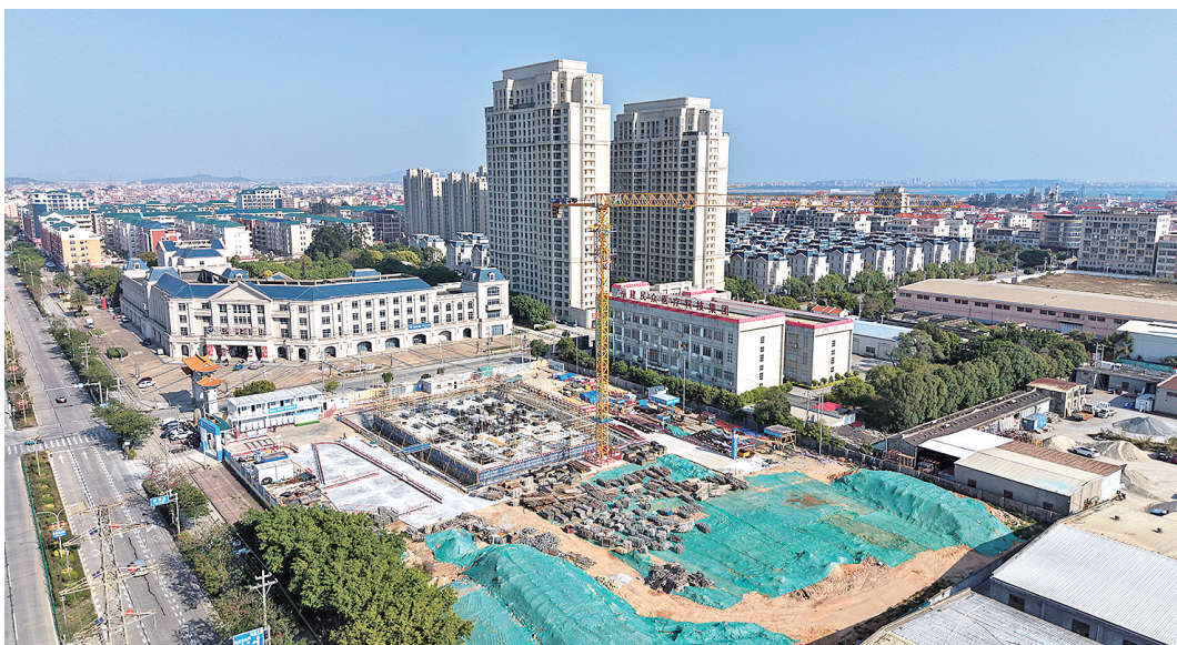
图为莆田健康产业园项目建设现场。全媒体记者 林罗晓 摄
