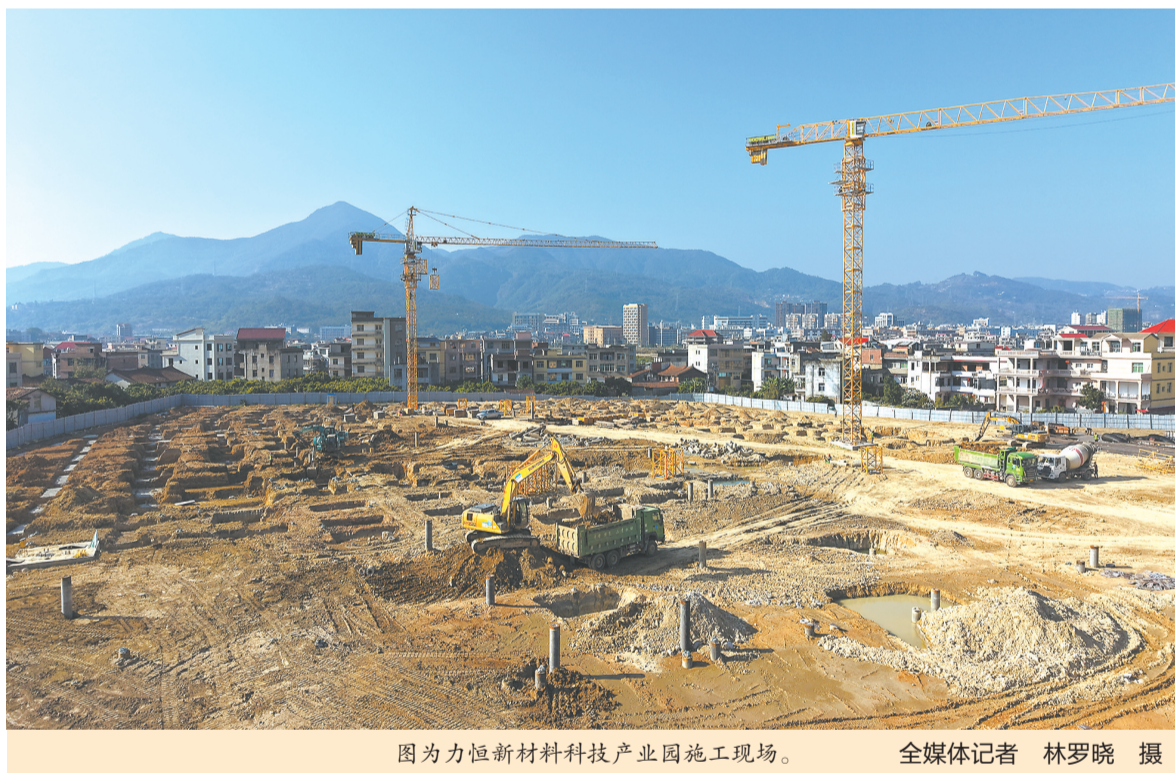
图为力恒新材料科技产业园施工现场。 全媒体记者 林罗晓 摄
