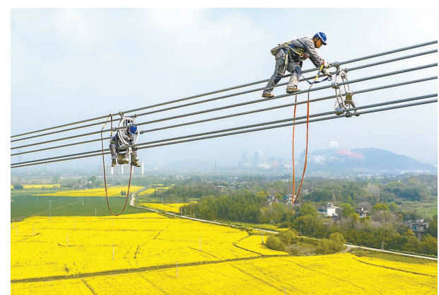
4月1日,在安徽省芜湖市繁昌区内,安徽送变电工程有限公司施工人员在甘肃—浙江±800千伏特高压直流输电工程施工现场作业。甘肃—浙江±800千伏特高压直流输电工程是国家“十四五”电力发展规划重点工程,工程贯通后每年可输送电能约360亿千瓦时。 新华社发
