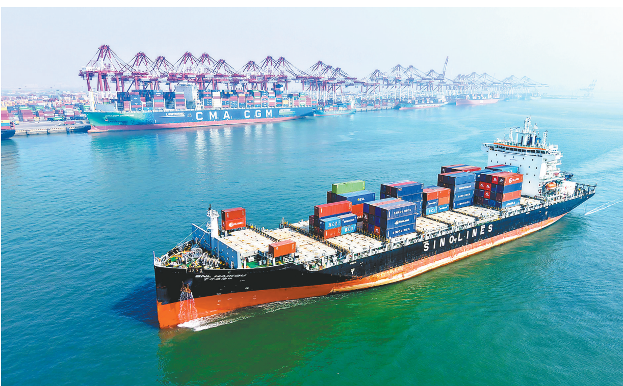
4月1日,在山东港口青岛港,一艘装载集装箱的货轮驶入港口(无人机照片)。2026年第一季度山东港口青岛港新开通7条集装箱航线。至此,青岛港一季度新开通航线已覆盖东南亚、澳大利亚、非洲、中南美等区域。 新华社发
