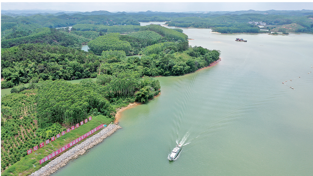
这是广西平陆运河平塘江口。平陆运河是西部陆海新通道骨干工程,全长134.2公里,可通航5000吨级船舶。目前,平陆运河整体工程建设有序推进,计划今年9月通航,建成后打通中国西南地区经西江干流南下入海的江海联运大通道。
