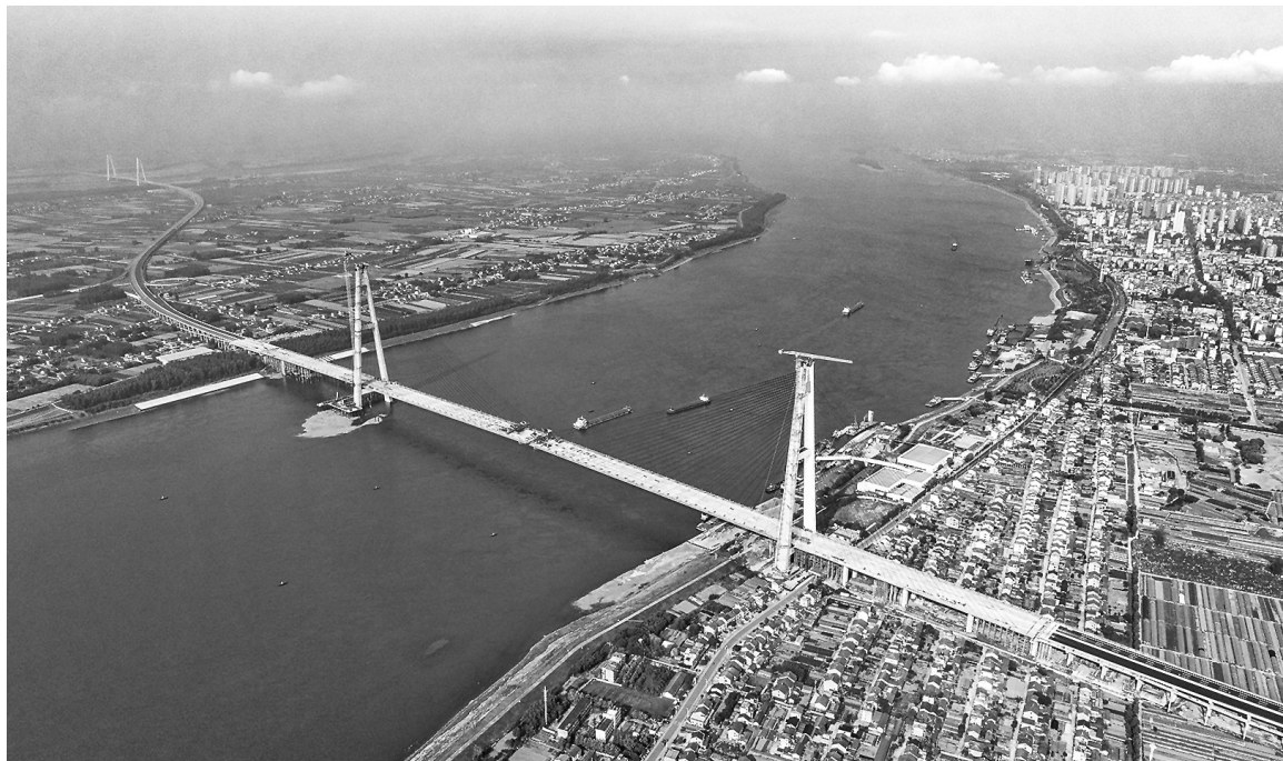
5月15日,枝江长江大桥顺利合龙,为2026年下半年项目建成通车奠定了重要基础。百里洲是长江枝江段一座大型江心洲。长期以来,洲上的居民出行只能依靠轮渡。大桥建成通车后,百里洲两岸群众过江时间由数小时缩短至5分钟,提升了长江经济带公路网的运行效率,增强长江中部干线的过江能力,为区域协同发展打通关键脉络。 新华社记者 肖艺九 摄
