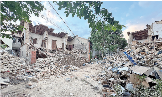
图为东阳村许多老宅坍塌。 陈建雄 摄
