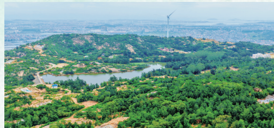
秀屿区东峤镇铁炉村鹭峰山石头山复绿工程
