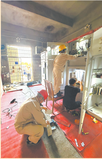
抢修人员争分夺秒促恢复供电。
