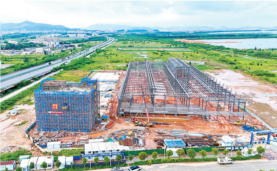
兆纬绿碳新材料智造基地项目提速建设。
