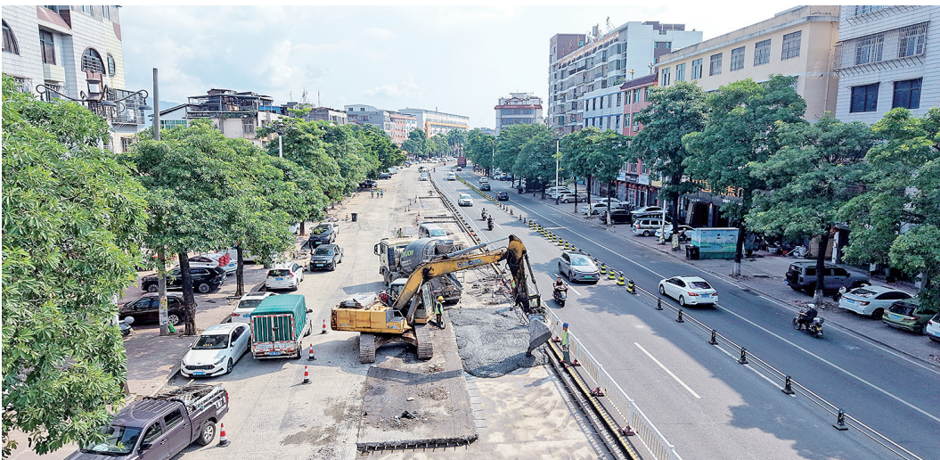
图为国道324线涵江区国欢镇塘头村至白塘镇新港村段施工现场。全媒体记者 林罗晓 摄
