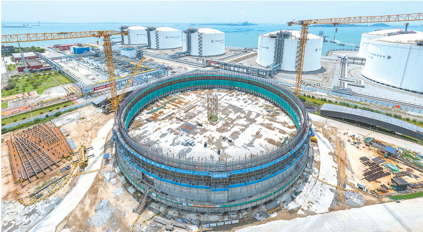
作为我省首座27万立方米地面全容式储罐，湄洲湾“绿能港”7号LNG储罐正在进行墙体浇筑等施工，建成后将大大提升区域储气调峰能力。图为该项目建设现场。
