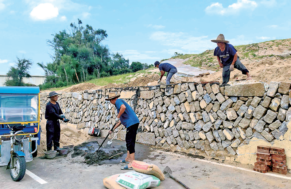
施工队抢抓雨后有利天气，修复损毁挡墙。
