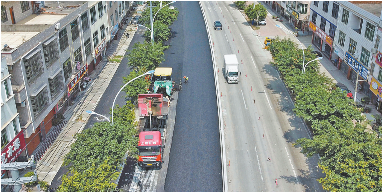
国道G228线灵川东进至笏枫公路段提级改造工程已进入“白改黑”,目前北半幅封闭铺设沥青,力争本月中旬实现半幅通车。 全媒体记者 杨怡玲 摄
