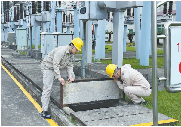
图为莆田供电公司变电运维人员检查电缆沟积水情况。
