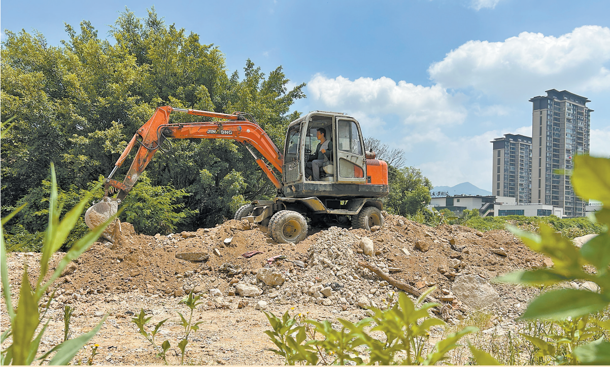
我市大力推进易涝点整治，确保排水安全，畅通出行环境。图为连日来，在荔涵大道与洞九线交叉路口，挖掘机在挖槽埋管。
