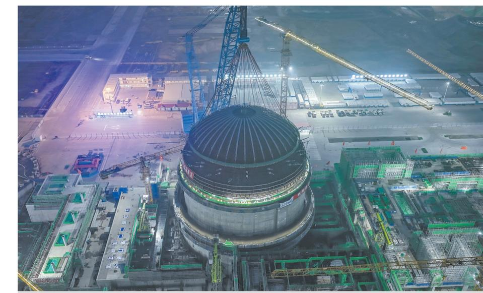
这是7月25日拍摄的徐大堡核电项目3号机组穹顶吊装施工现场。当日,徐大堡核电项目3号机组顺利实现穹顶吊装就位。徐大堡核电项目3、4号机组建成后,预计每年可提供160亿千瓦时以上清洁电力,相当于年节约燃煤570万吨,年减少二氧化碳排放量1680万吨,对于保障我国能源安全、优化能源结构具有积极作用。
