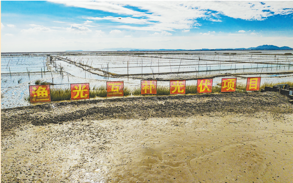
连日来,涵江兴化湾渔光互补光伏电站项目加快建设。
