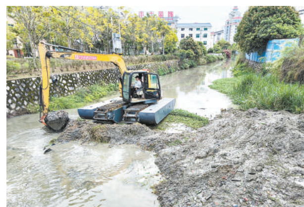
连日来,在涵江区梧塘镇河道施工现场,挖掘机、装载机机械进行滩地整理、河道清淤疏浚等作业,数十名工人配合机械设备,对河道边坡进行混凝土衬砌加固。图为河道清淤疏浚现场。陈雨情 章宇安 摄
